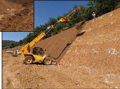
Rivestimento anti-erosivo ad elevata rigidezza di scavi definitivi
