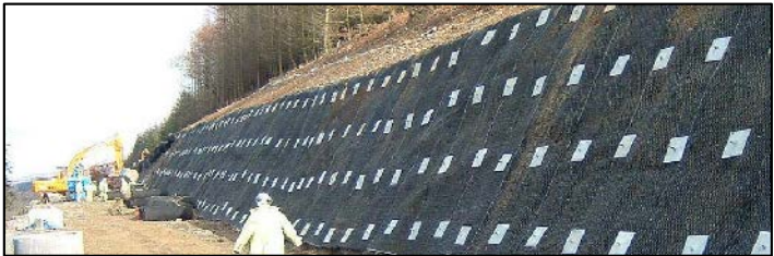
Rivestimento anti-erosivo di scavi definitivi
