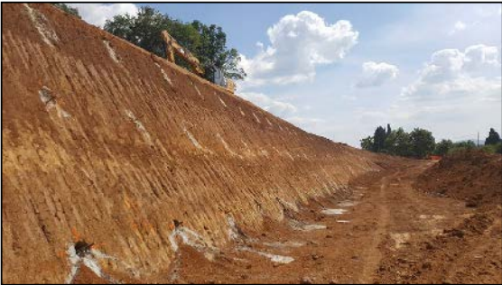
Rivestimento anti-erosivo ad elevata rigidezza di scavi definitivi
